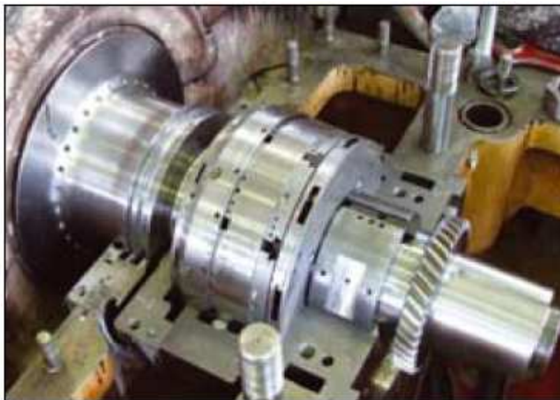
Рисунок 2 – Подшипник опорно-упорный ПДУ-120/260 во время монтажа.
