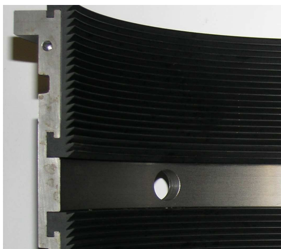
Рисунок 3 – Лабиринтное уплотнение из полимерного материала.
